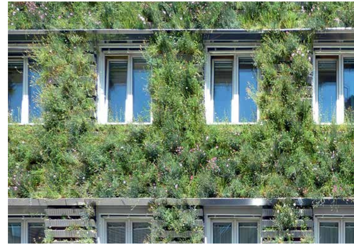
ABBILDUNG 2 ▶ Wandgebundene Fassadenbegrünung mit Dämmwirkung, Fassade Magistratsabteilung 48, Wien.
